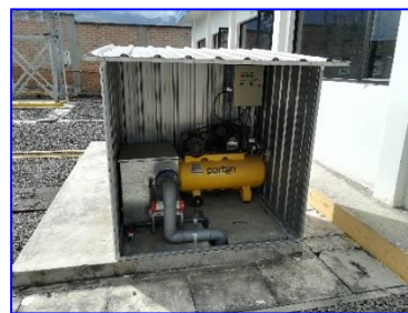
Sistema de Bombeo en caso de derrames.
