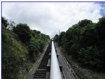
Tubería de Longitud total 410 m, caída de presión 125 m
