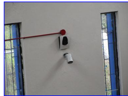
Sensor de humo por reflexión de haz de luz
