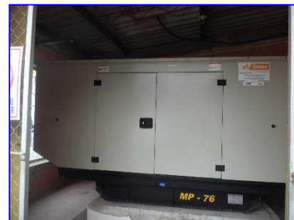
Grupo Electrónico marca Modasa 87 kva, para respaldo del edificio.
