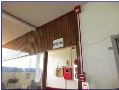
Lámparas estroboscópicas y pulsadores manuales
