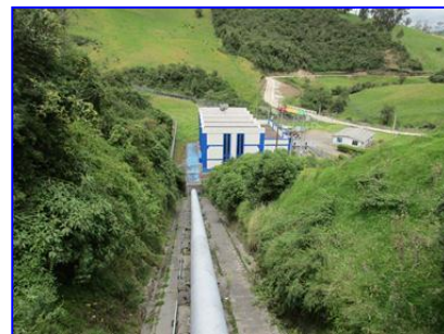
Tubería de Longitud total 410 m, caída de presión 125 m
