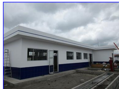
Cuarto de Equipos Nuevos en Construcción
