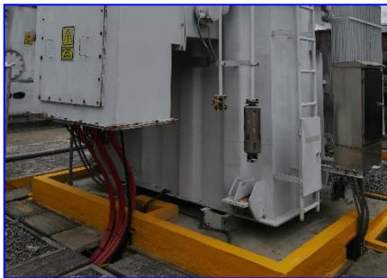
El Transformador de Potencia cuenta con un cubeto de retención
