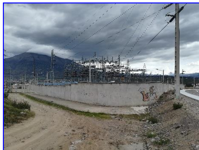
Lindero Este. - Predios privados sin construcciones.
