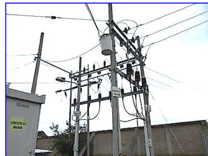
Transformador Servicios generales 15 kVA
