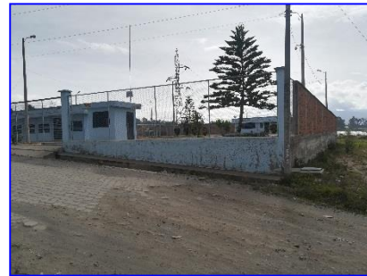
Puerta de ingreso con cerco de mallas metálicas.
