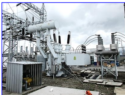
Transformador de Potencia 5 MVA
