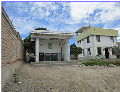
Orden y limpieza satisfactorio
