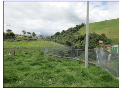
Cerramiento perimetral de malla
