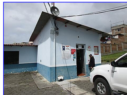
Cuarto de Equipos
