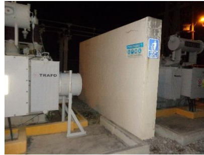
Transformador de elevación de 5 / 6,25 MVA, relación de voltaje 4,16 / 34,5 kV. Se observa un muro cortafuego entre transformadores
