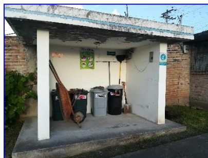
Cerco Eléctrico sobre el muro perimetral
