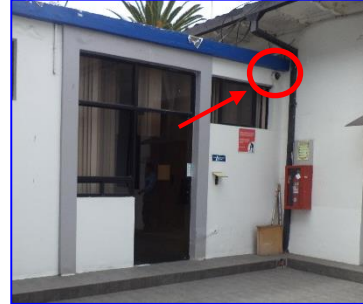
Cámaras tipo domo para vigilancia exteriores.
