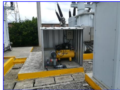
Sistema de Bombeo en caso de derrames.
