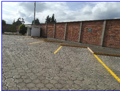
Cerco Eléctrico sobre el muro perimetral
