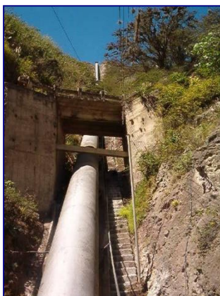
Tubería de presión de distinto diámetro y longitudes, se pinta cada 3 años, no cuenta con protecciones galvánicas
