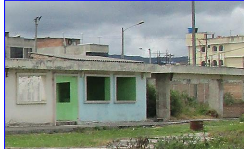
Bodega de Transformadores
