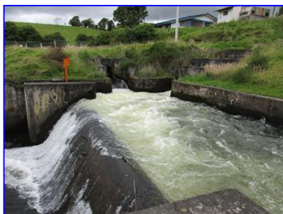
Vertedero de exceso
