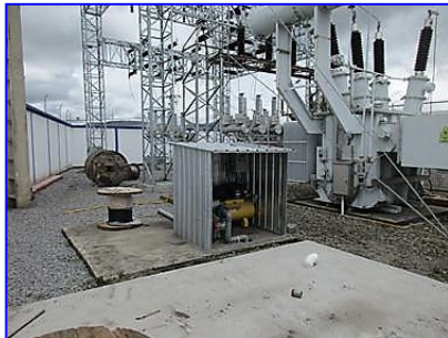
Sistema de bombeo en caso de derrame
