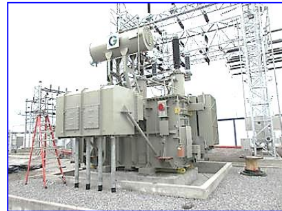
Nuevos Pórticos y Transformador de Potencia 25 MVA
