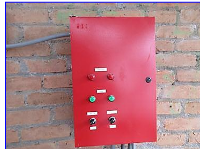
Panel del sistema hídrico contraincendios
