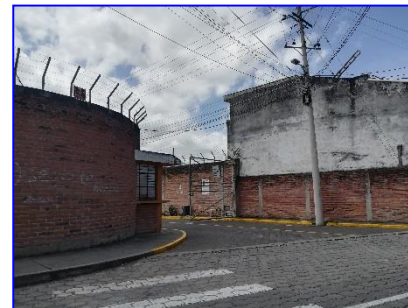
Lindero Oeste. – calle 13 de abril
