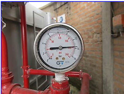
Manómetro de presión del sistema contraincendios
