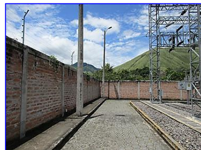
Cerramiento perimetral de ladrillo
