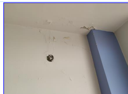
Daño del recubrimiento del piso en varias áreas del edificio
