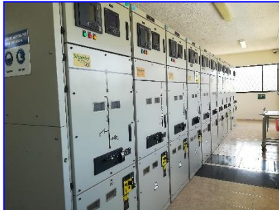
Celdas de media tensión de 69 Kv de la Sala de Control
