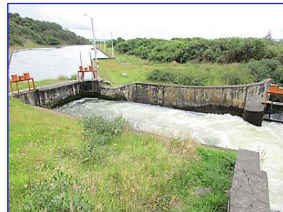
Boca toma de captación lateral de las aguas de los ríos Chico y Grande
