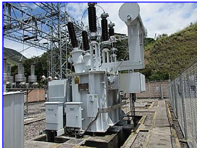
Transformador de Potencia 5 / 6,25 MVA
