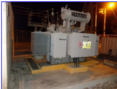
Transformador de elevación de 5 / 6,25 MVA, relación de voltaje 4,16 / 34,5 kV. Se observa un muro cortafuego entre transformadores
