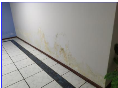
Recubrimiento de paredes desprendido
