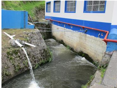
Canal de descarga de las aguas turbinadas, paredes recubiertas con piedra
