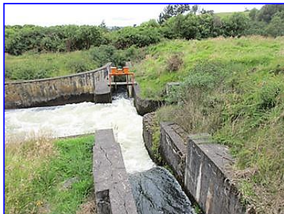
Boca toma de captación lateral de las aguas de los ríos Chico y Grande
