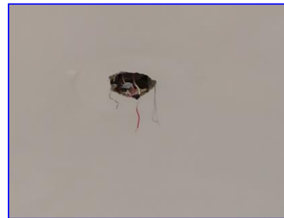
Cables sueltos, producto del desmontaje de lámparas
