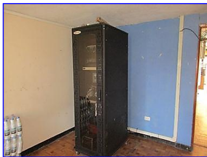
Equipos de comunicación SCADA
