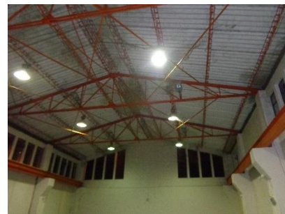
Casa de Maquinas, resistencia al fuego 2 horas
