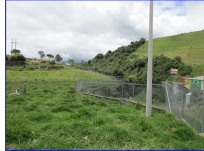
Cerramiento perimetral de malla
