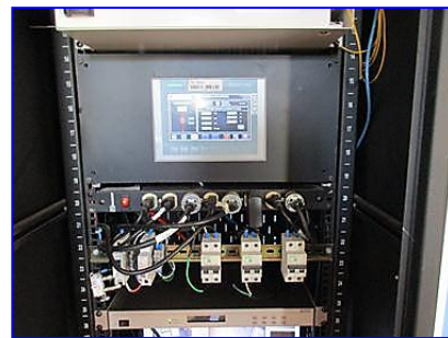
Equipos de comunicación SCADA
