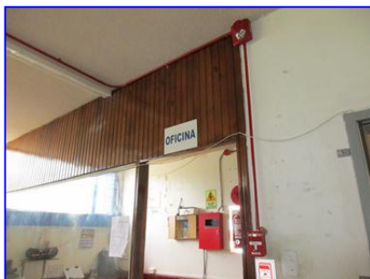
Lámparas estroboscópicas y pulsadores manuales
