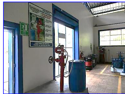
Sistema contra incendios por Chorro de Espuma
