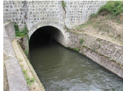
Canal de descarga de las aguas turbinadas, paredes recubiertas con piedra
