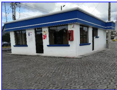
Casa del Operador
