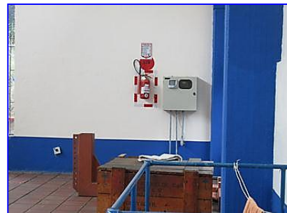
Extintores portátiles ubicados a 1,60 m de altura desde el piso
