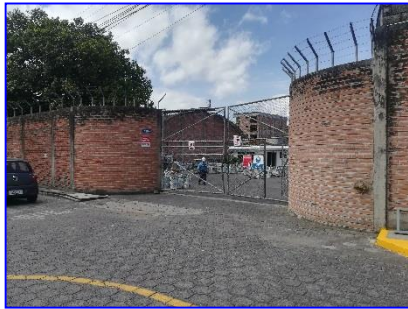
Ingreso a las instalaciones de la Bodega Ibarra, se observa el cerco eléctrico.
