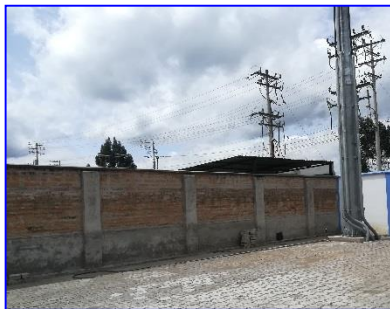
muro perimetral de 2 metros de altura
