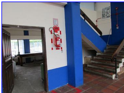
Extintores portátiles ubicados a 1,60 m de altura desde el piso
