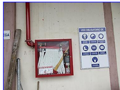
Panel del sistema hídrico contraincendios
