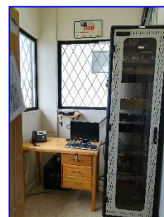
Centro de comunicaciones en la Casa del guardia.
