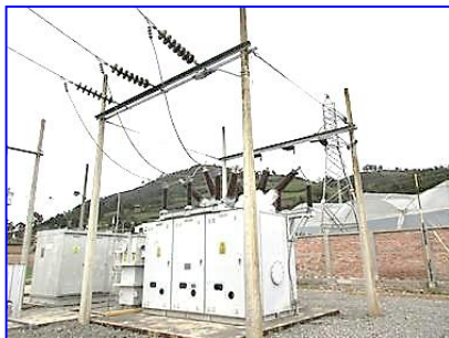
Transformador de Potencia 2,5 MVA
