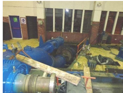
Unidades de Generación, lado derecho unidad # 2 en mantenimiento mayor
