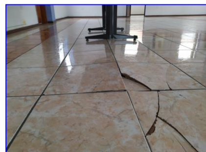
Daño del recubrimiento del piso en varias áreas del edificio
