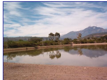
Reservorio de 50.000 m 3 de capacidad, paredes de hormigón armado.
