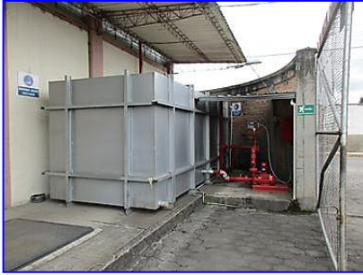
Cisterna de almacenamiento de agua para el sistema contraincendios
