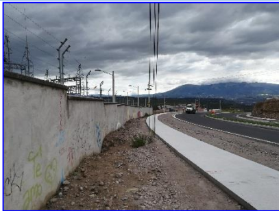
Lindero Norte. - Predios privados sin construcciones.
