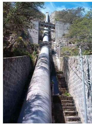
Tubería de presión de distinto diámetro y longitudes, se pinta cada 3 años, no cuenta con protecciones galvánicas
