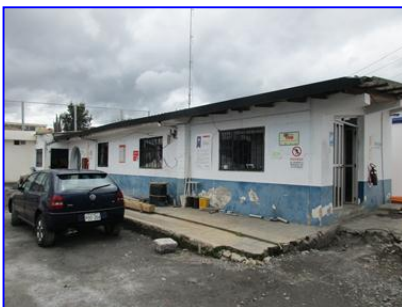
Cuarto de Equipos Antiguos
