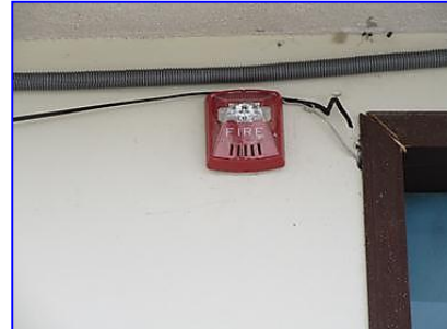
Lámpara estroboscópica
