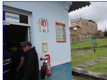
Extintor de incendios portátil
