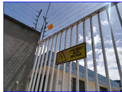
Cerco Eléctrico sobre a lo largo de todo el muro perimetral
