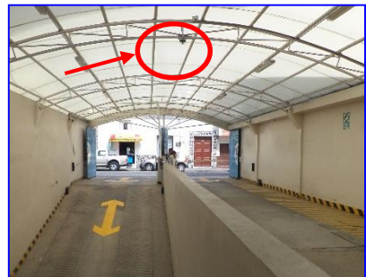
Cámaras tipo domo en acceso vehicular
