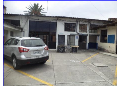
Patio posterior del Edificio.
