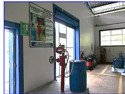
Sistema contra incendios por Chorro de Espuma
