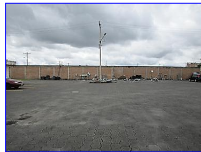
Cerramiento Perimetral de ladrillo
