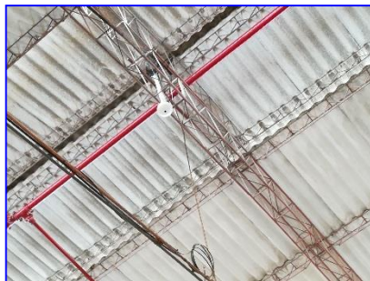
rociadores automáticos de activación temprana distribuidos en toda la bodega
