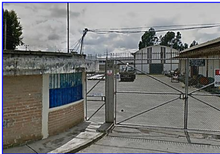
Garita del Guardia de Seguridad (Puerta Principal)
