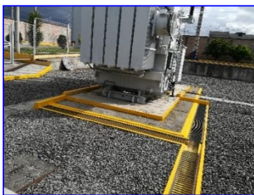
El Transformador de Potencia con cubeto de
