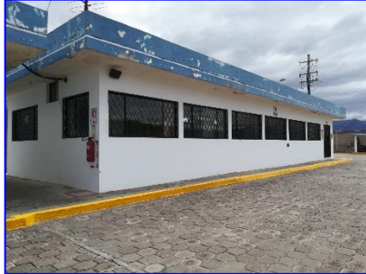
Fachada de la Sala de control
