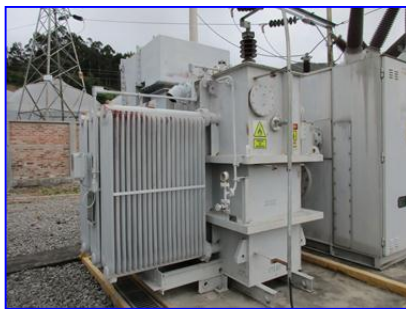
Transformador de Potencia 2,5 MVA
