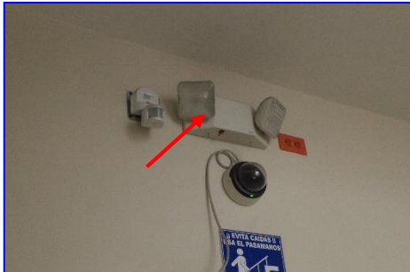
Luces estroboscópicas
