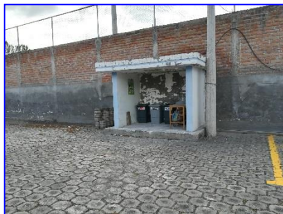
Cerco Eléctrico sobre el muro perimetral
