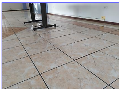
Daño del recubrimiento del piso en varias áreas del edificio
