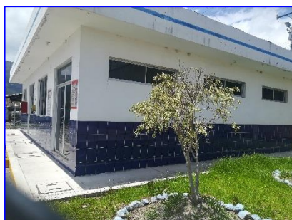
Casa del Operador
