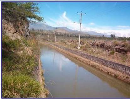
Canal de conducción de agua tipo abierto, paredes recubiertas con piedra.
