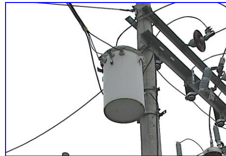
Transformador Servicios generales 15 kVA
