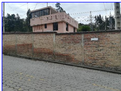
muro perimetral de 2 metros de altura
