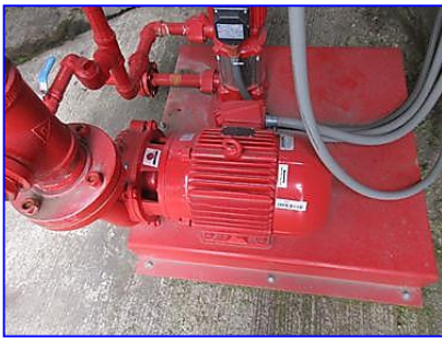
Motobomba, y bomba jockey del sistema contraincendios
