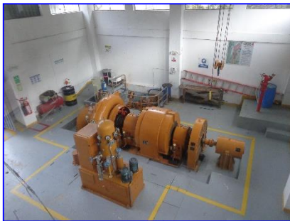
Unidad de generación hidráulica de 980 kW de potencia
