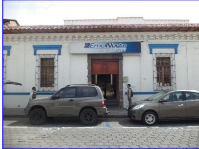
Fachada del edificio Antiguo
