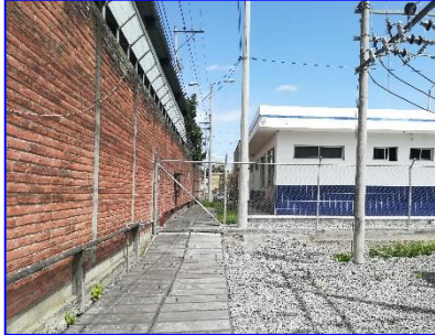
Cerco Eléctrico sobre el muro perimetral
