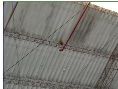
rociadores automáticos de activación temprana distribuidos en toda la bodega
