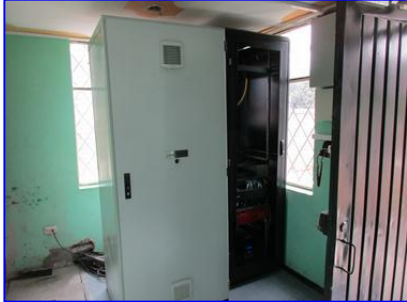
Equipos de comunicación SCADA
