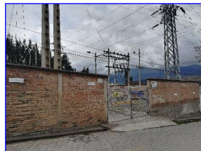
Puerta de ingreso principal
