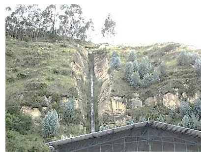
Tubería de presión de 90 m, caída 65 m
