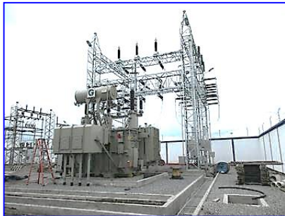
Nuevos Pórticos y Transformador de Potencia 25 MVA
