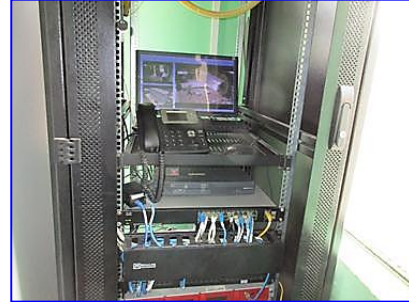
Equipos de comunicación SCADA
