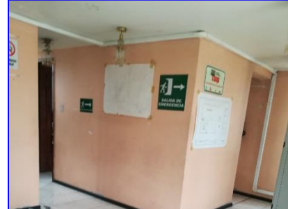
Casa del Operador (exterior e interior)
