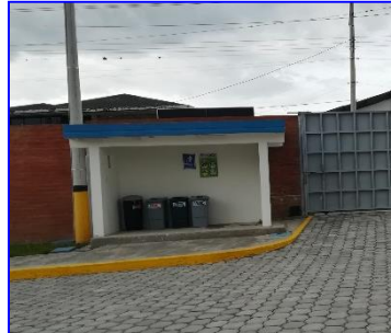
Caseta de limpieza junto a la entrada.
