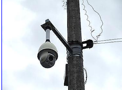
Cámara de seguridad externa
