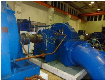
Unidades de Generación, lado derecho unidad # 2 en mantenimiento mayor
